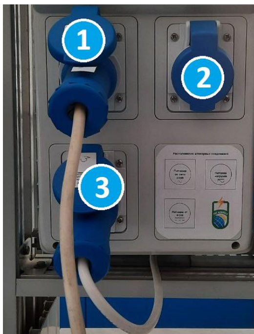
1 - 220В желіден қуат; 2-инвертордан 220В жүктеме қуаты; 3- ФЭМ инверторына қуат беру
